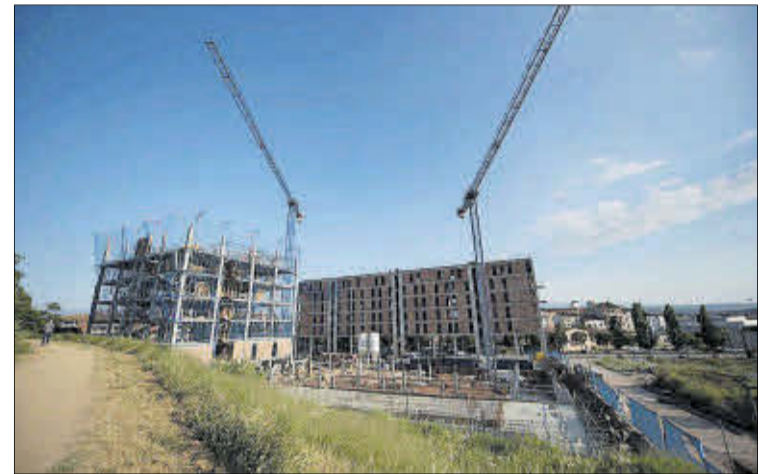
Construcció d'una promoció de pisos
