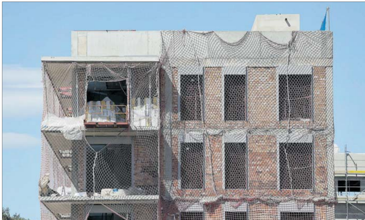
La construcció d'habitatges busca tornar el més aviat possible a la normalitat. ANIOL RESCLOSA
